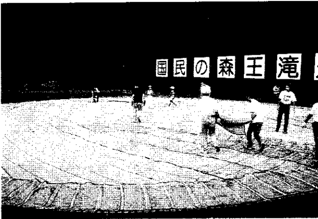
写真-5 緑化工事体験コース
