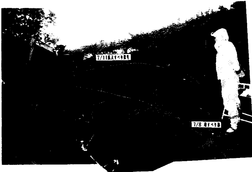
写真-4 7月11日拡大地すべり発生
