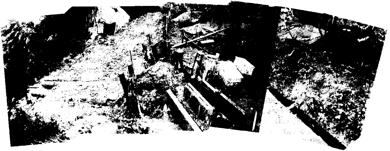
写真-5 仮応急工事完了
