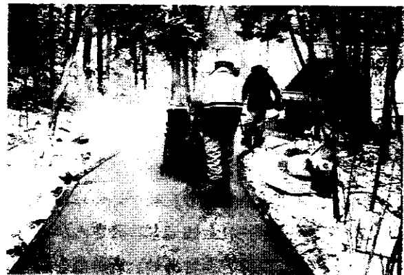
(写-10 舗装施工中)
