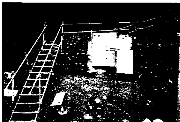
(写-13) 勾配がきつく標識が不備。
