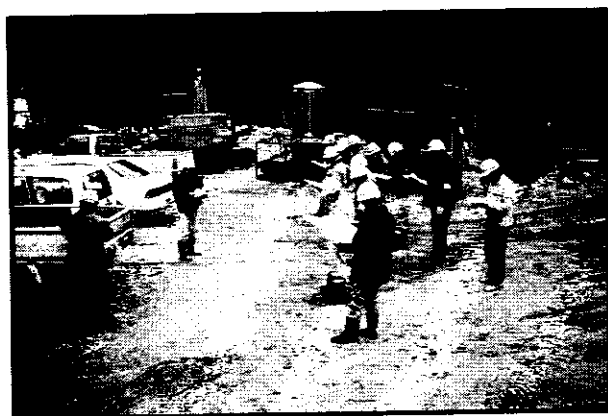
(写-6) 工事概要の説明
