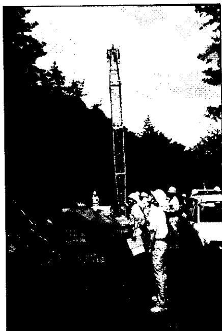
(写-8) 索道施設の点検
