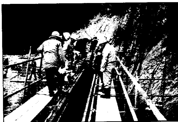
(写-7) 足場と手摺の点検
