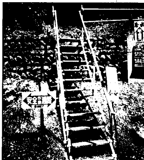
(写-14) 昇降しやすくし、標識も掲示。単管の端にキャップを着け接触での怪我を防止した。
