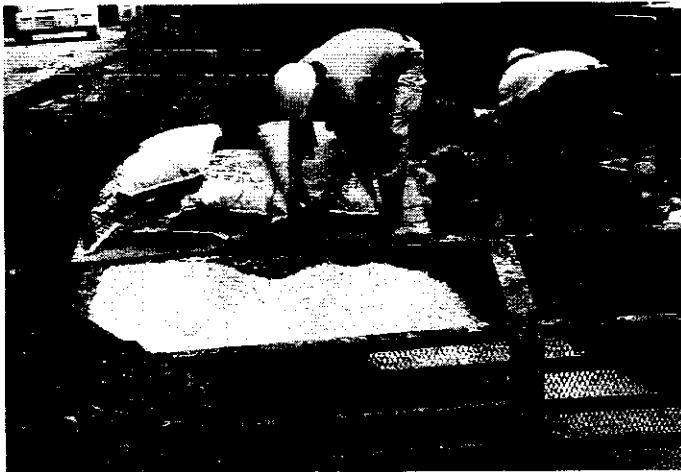
写-7 浄化材詰め込み
