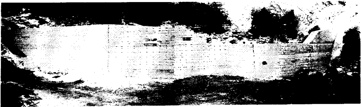
写真-3 既設のコンクリート谷止工
