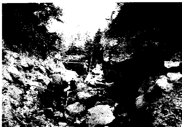
写真-1 土砂流出した跡
