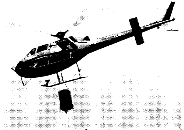
写-1 ヘリコプターによる施工
