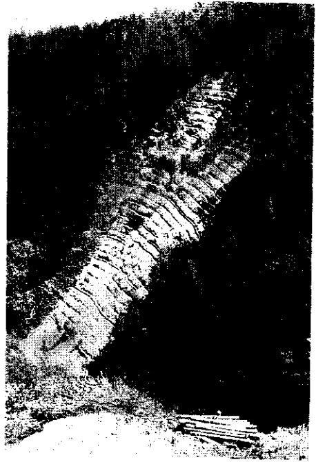
写-2 基礎工施工状況
