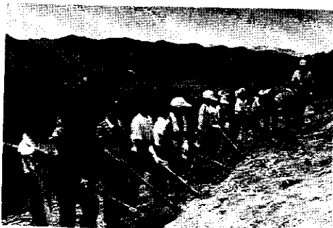
写-3 土留工の床拵え
