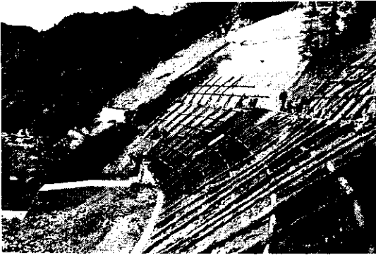
写-4 丸太のり枠工組立及び 土のう伏設状況
