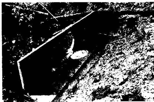
写-2 擁壁設置完了
