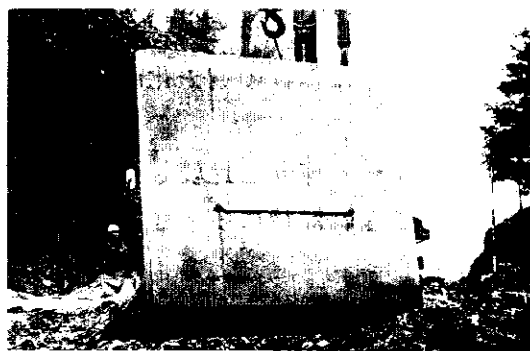
写-1 擁壁吊り込み中
