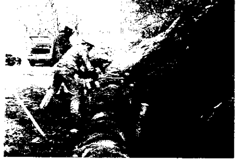
写-4 杭を打ちチューブを張る
