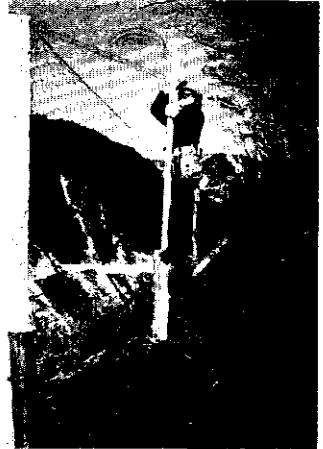
写一 杭の上に登り作業中
