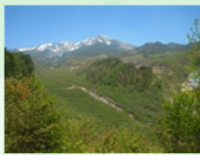
御岳国有林 昭和59年に発生した長野県 西部地震復旧地 御嶽山噴火災害の対応
