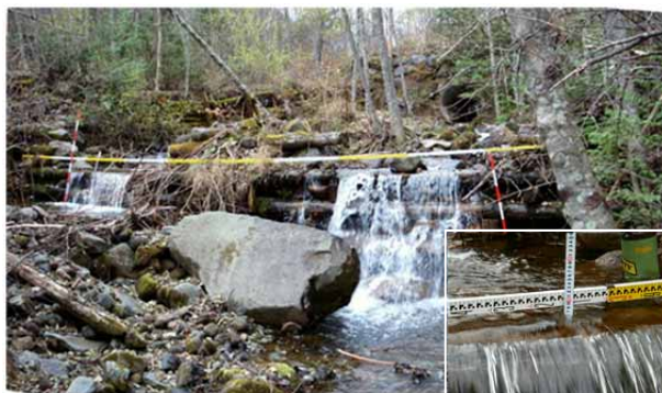
床固工の調査（木曽署管内）
