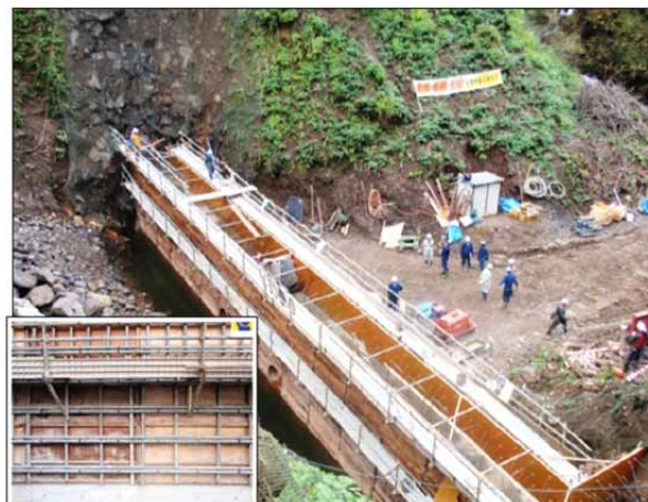
国産材型枠合板を用いた治山事業の実証実験 土谷川地すべり防止工事（姫川地区民有林直轄）
