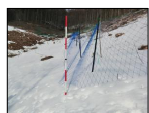
日陰の残雪多い箇所 支柱の傾斜
