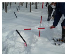
ネットに引っ張られ支柱が大きく傾斜
