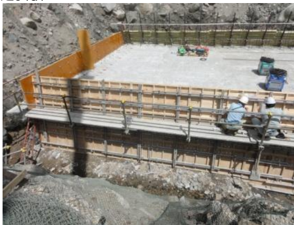
スギ・ヒノキ型枠用合板とラワン型枠用合板との たわみ比較試験（富山署管内）
