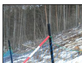
日陰の残雪多い箇所 ネットのずり落ち
