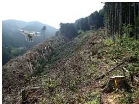
ドローンによる林縁伐根の確認状況
