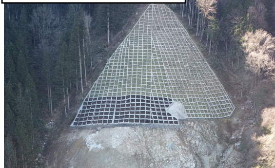
R7年度末の復旧状況(継続工事)
