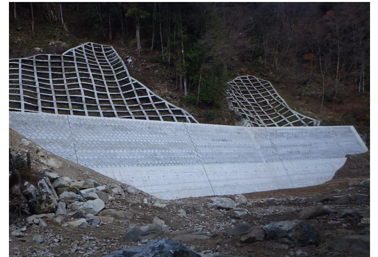
林道災害復旧工事（落合国有林）
