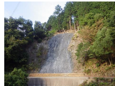
林道の山留に採用した丸太土留工
