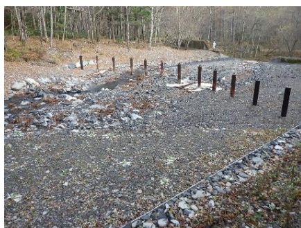
流木を捕捉するスリットの据付け 独立基礎型流木捕捉工(塩尻市 奈良井国有林)
