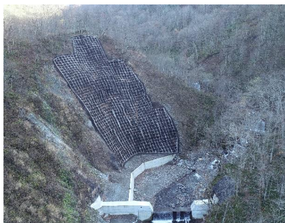
床固工・山腹工(糸魚川市 ウド川地区)
