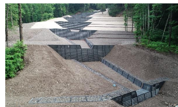
谷止工(大町市 籠川谷国有林)
