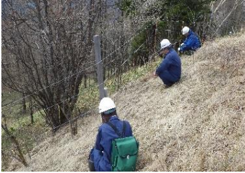
電気柵の設置
