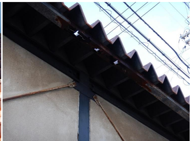
雨樋破損部分
