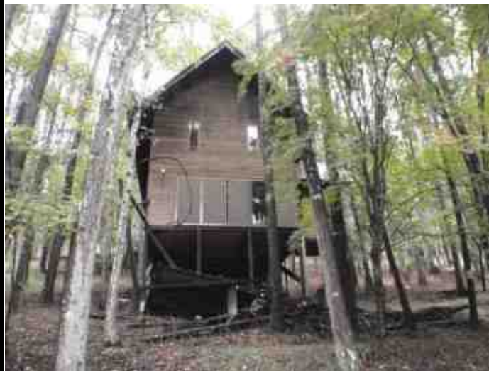
南側道路から撮影
