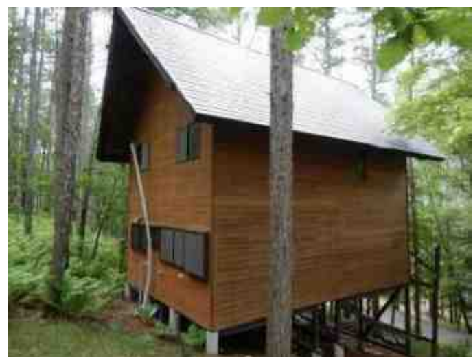
建物北西側から撮影
