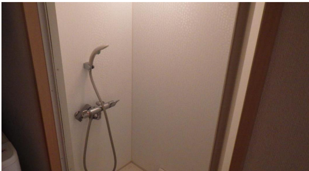
解体物件 ① シャワー室
