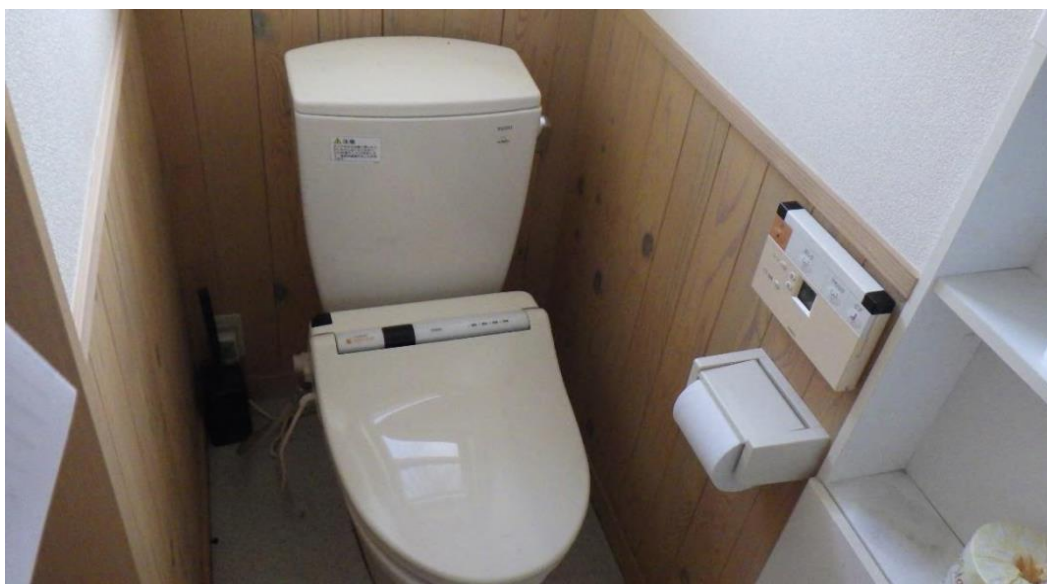
解体物件 ① トイレ
