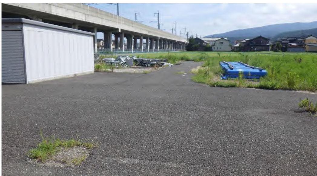
解体物件 ④ 舗装
