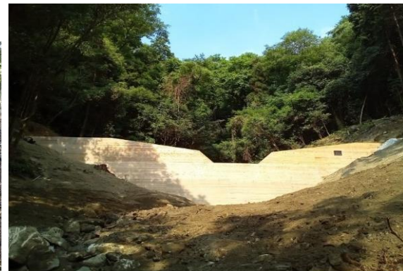
復旧治山工事（残存型枠）
