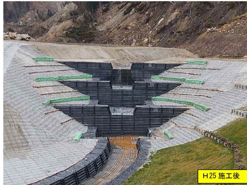
2・3・4号鋼製床固工（下流から上流）
