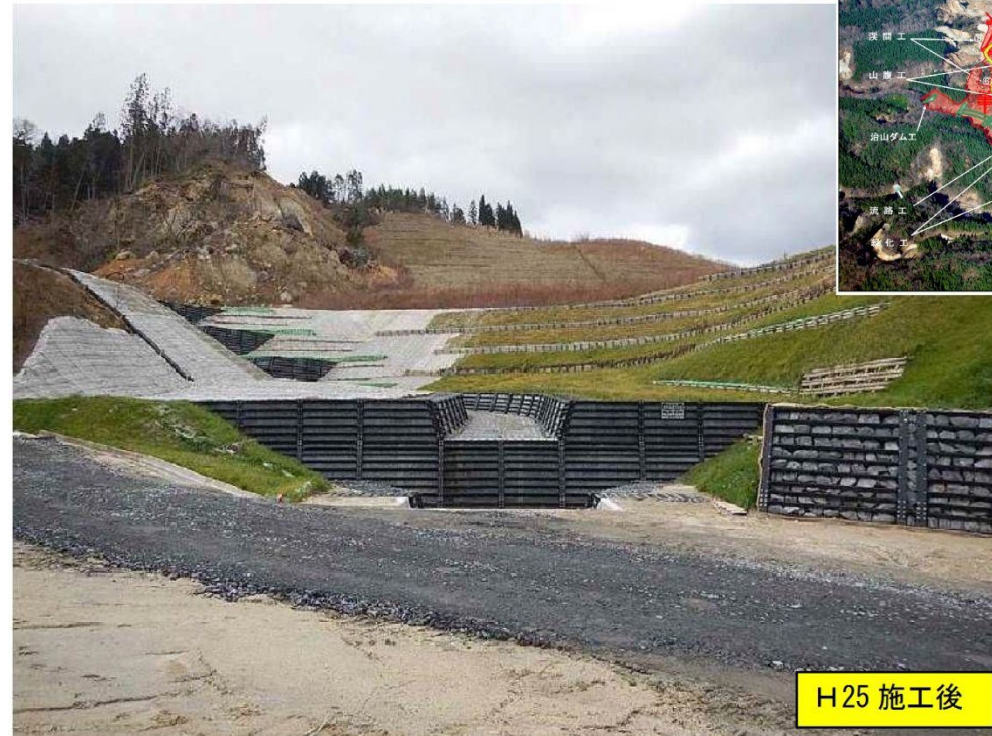
1号鋼製床固工（下流から上流）
