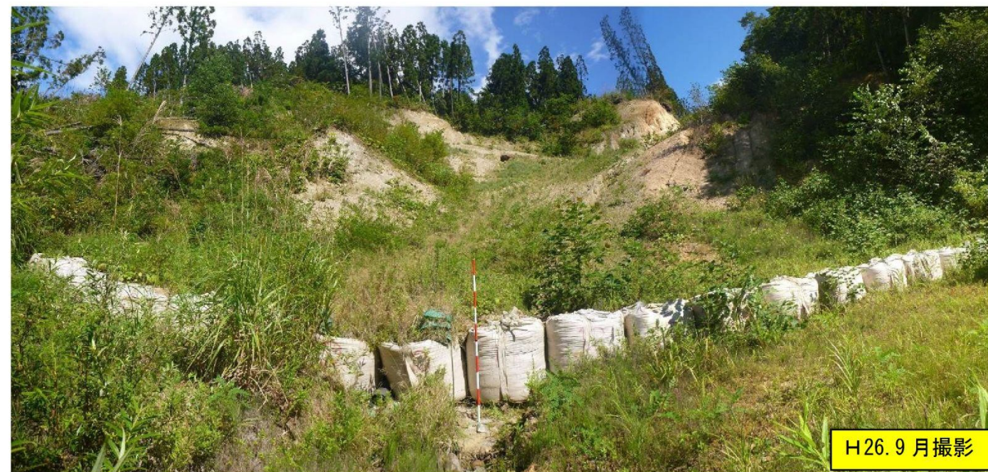
フレコンパック土留工・植生土のう水路工・暗渠パイプ敷設
