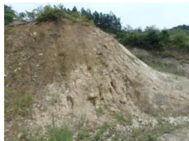
写真 2.6 作業道脇のガリー侵食
