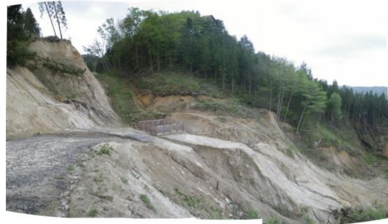
写真 2.4 集水井周辺のガリー侵食（平成 24 年 5 月）
