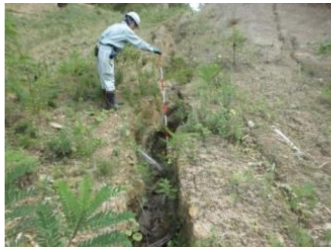
写真 2.5 集水井下斜面のガリー侵食
