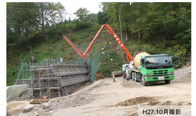
右岸袖部のコンクリート打設風景
