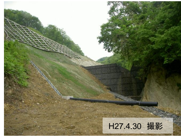
ニゴリ沢第二工区 [地すべり防止工事]
