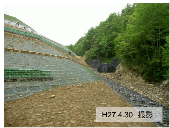
ニゴリ沢第一工区 [地すべり防止工事]
