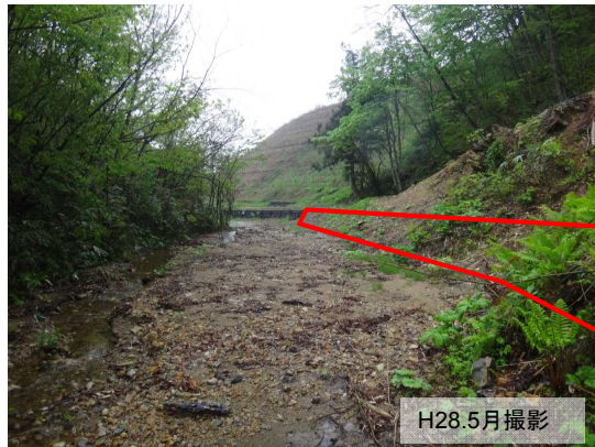
現況 上流より
