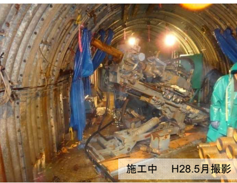
小股沢排水トンネル補修 [地すべり防止工事]
