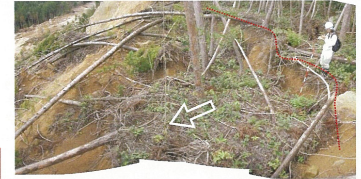
変形が少ない移動体の縁に連続する拡大亀裂
