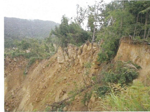
縦のクラックが発達する軽石凝灰岩
