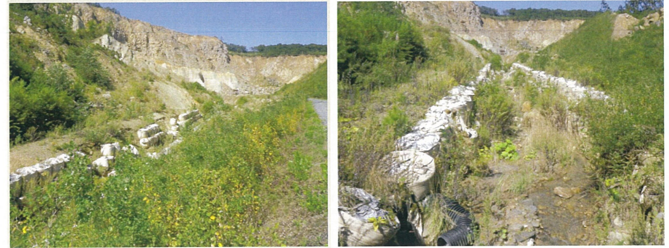
写真 2.5.8 ⑧区域の侵食状況
