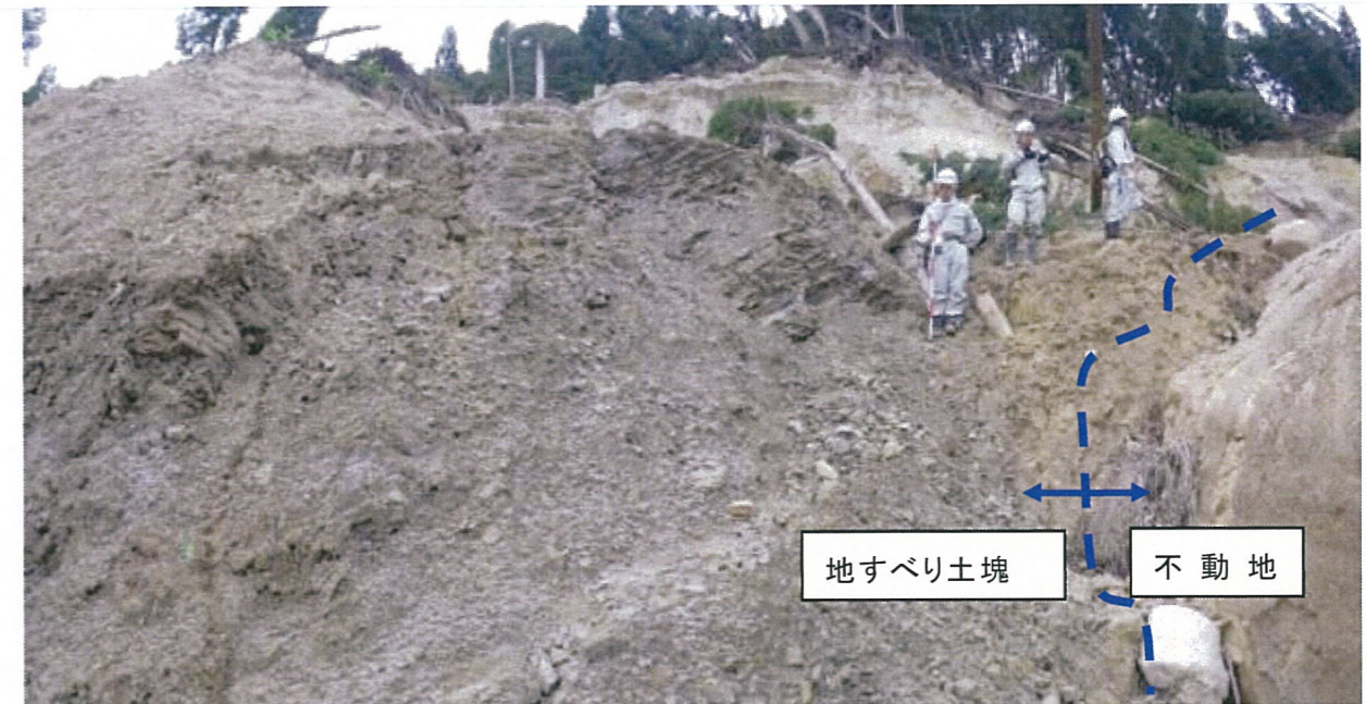
写真 2.5.4 地すべり発生当初の状況
