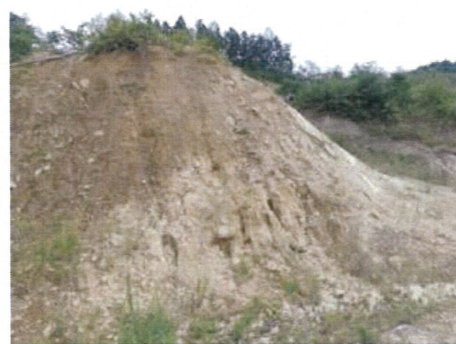
写真 2. 5. 7 作業道脇のガリー侵食
