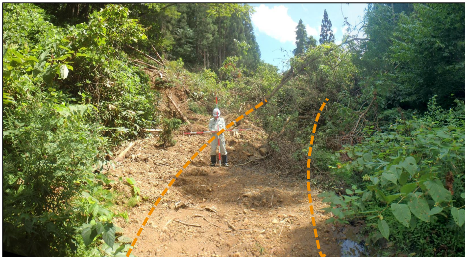
写真3. 町道への土砂流出状況
