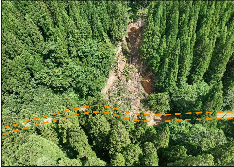
写真1. 崩壊地の状況（全景）
