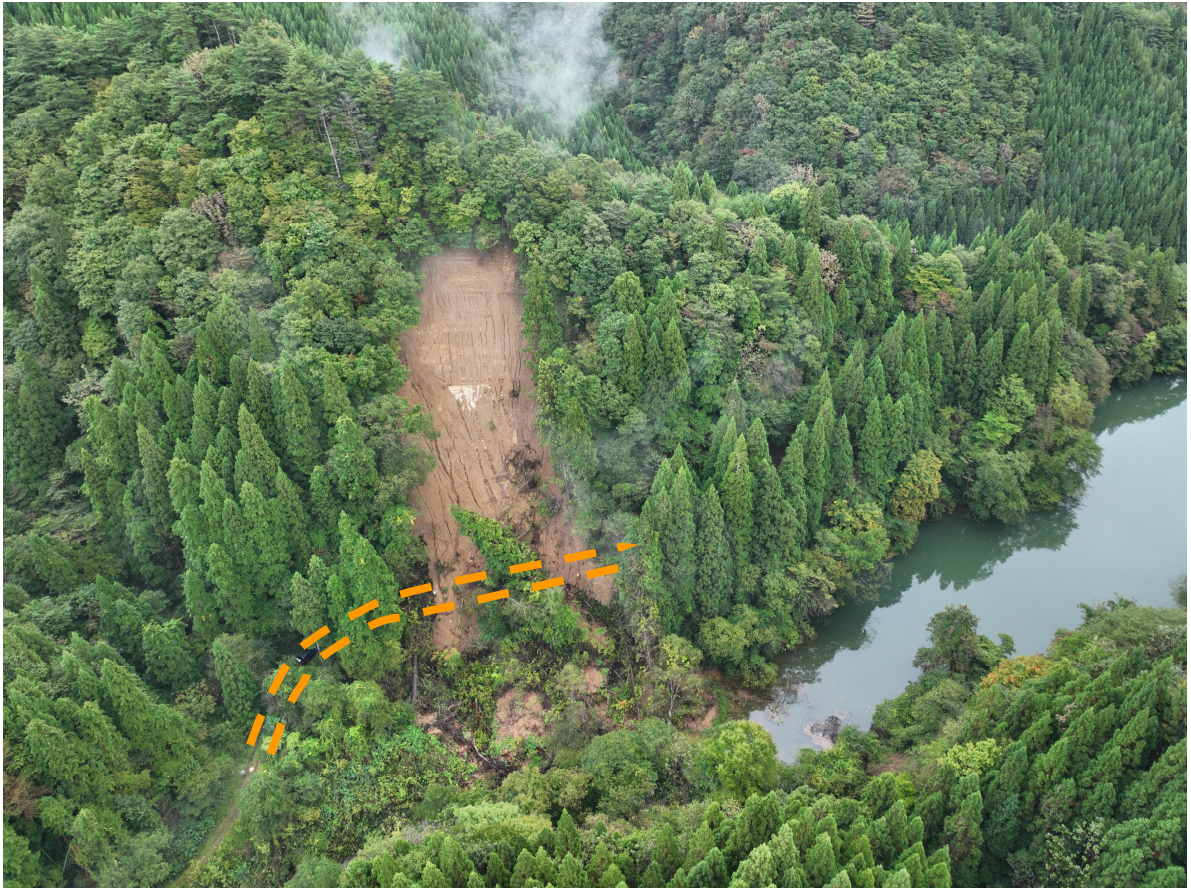
写真1.被災状況（上空から全景）
