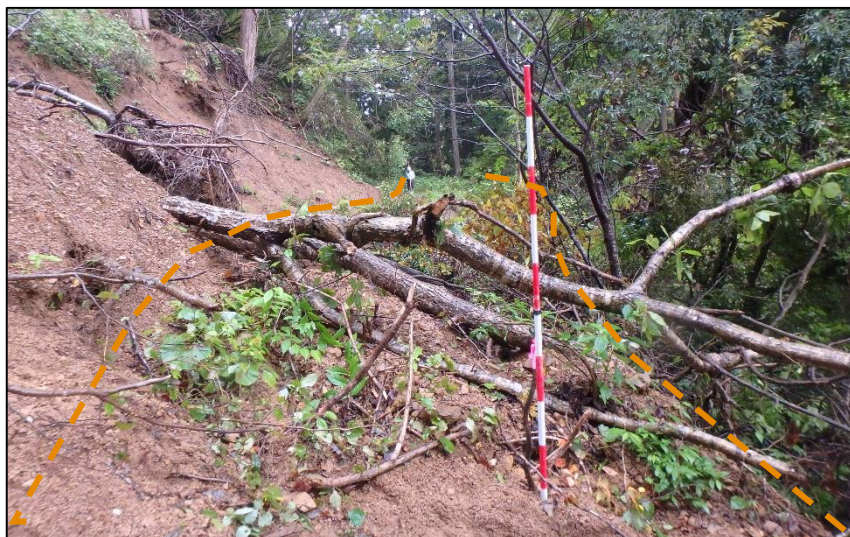
写真3. 長捨沢林道の被災状況
