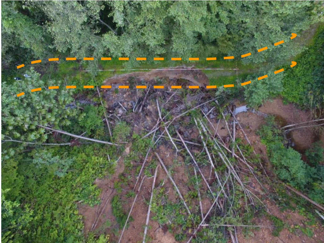
写真14.被災状況（上空から全景：箇所⑦）
