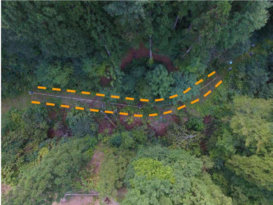
写真 2 2.被災状況（上空から全景：箇所①）
