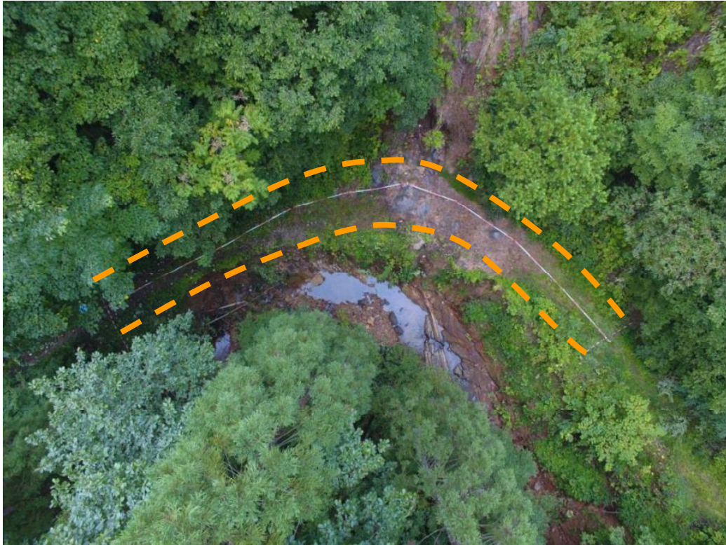
写真16.被災状況（上空から全景：箇所⑧）
