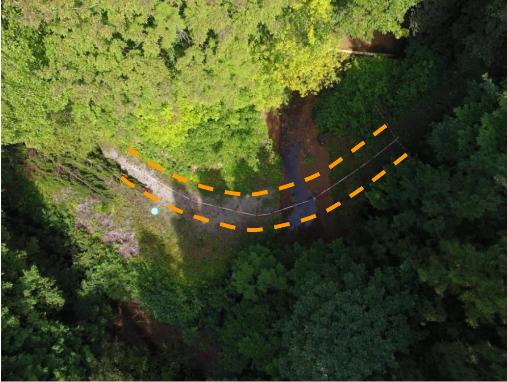
写真 2 0 .被災状況（上空から全景：箇所⑩）
