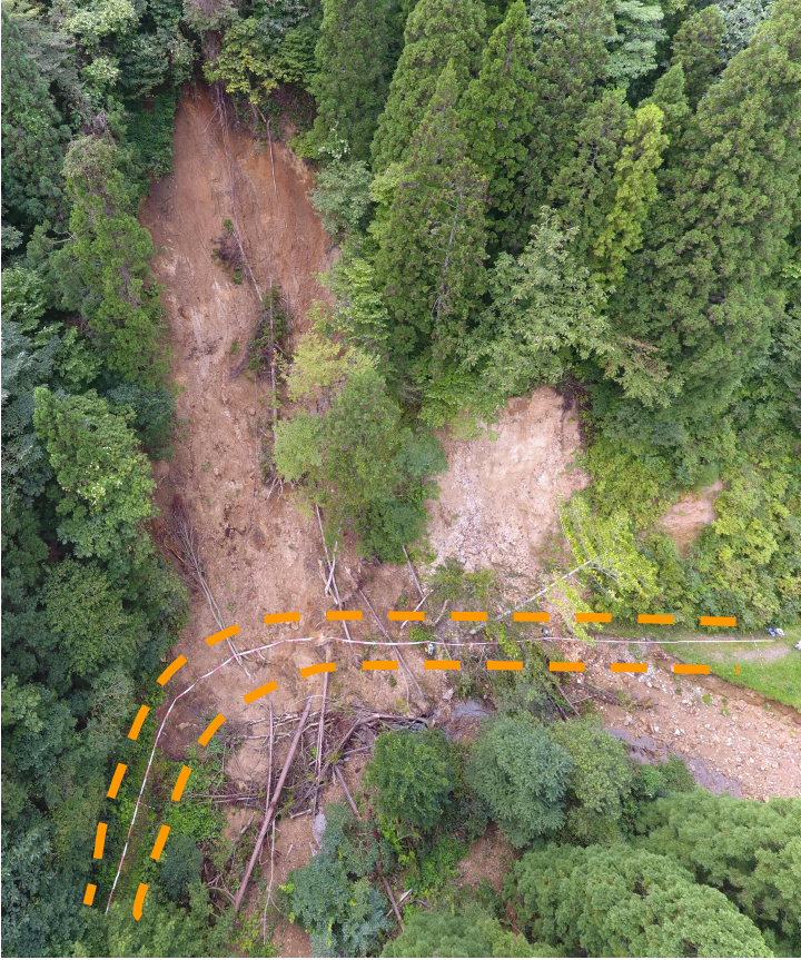
写真7.被災状況（上空から全景：箇所④）
