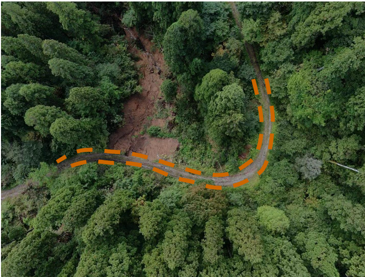
写真 3 .被災状況（全景：箇所②）
