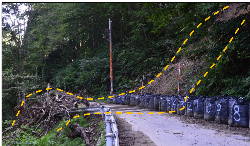
写真3. 県道への土砂堆積状況
