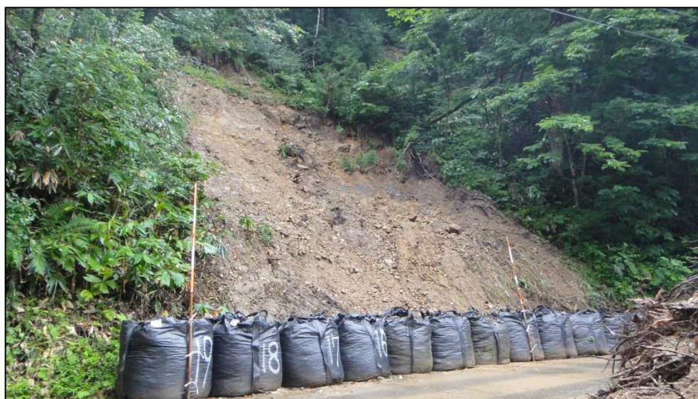
写真2. 崩壊地の状況（県道より）
