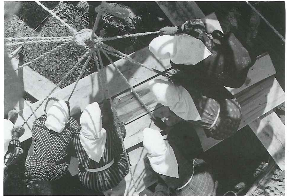
橋脚の打込み作業。(大開浜)
