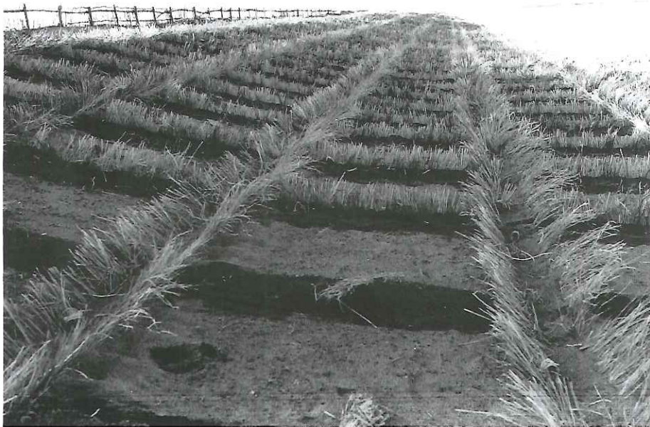
施工中のフラ静砂立工。(大開浜 S.33)
