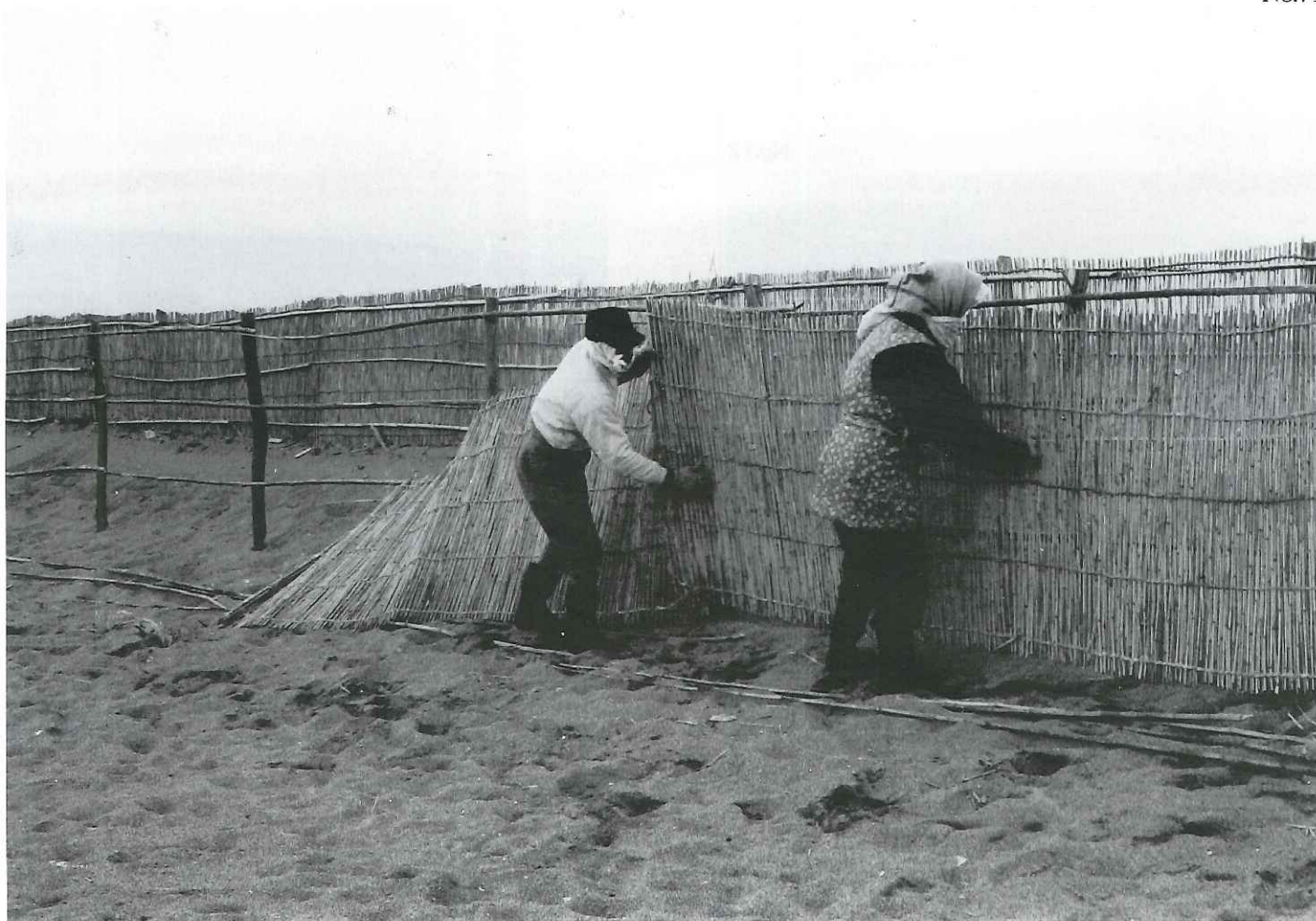
ヨシ簀を用いて防風柵を作る作業。
