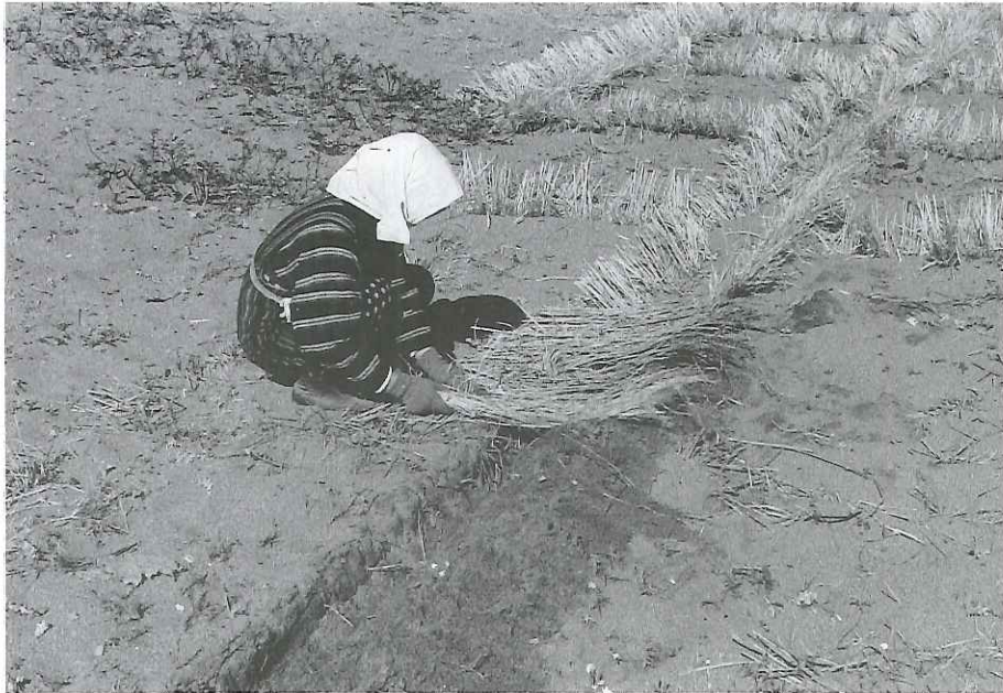
ワラ静砂立工の作業。(後谷地 S.31)
