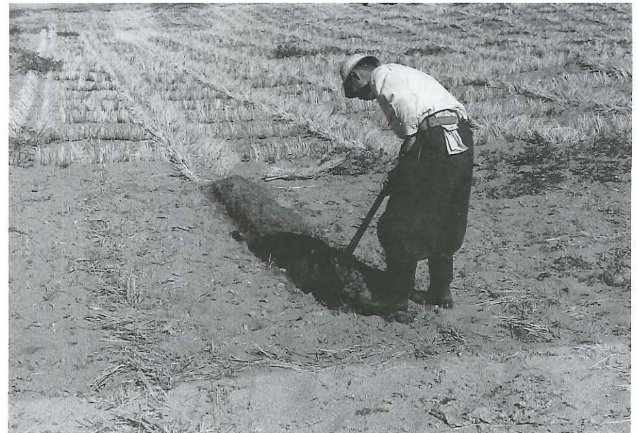
フラ静砂立工の作業。(S.31)
