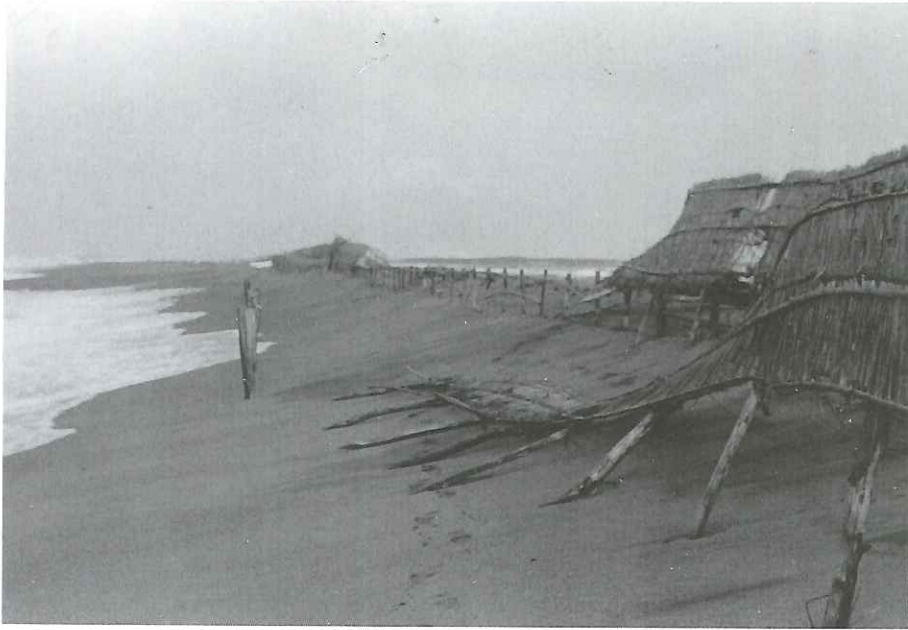
波浪によって破壊された防浪垣。(後谷地 S.32)
