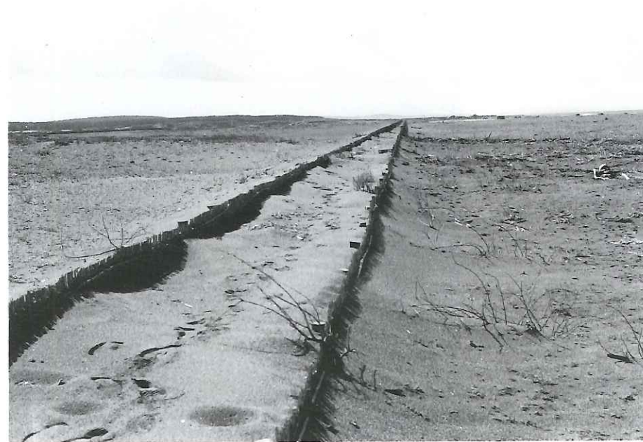
一列目の前後に堆砂したら、その後方に二列目の堆砂垣を造成する。(大開浜)
