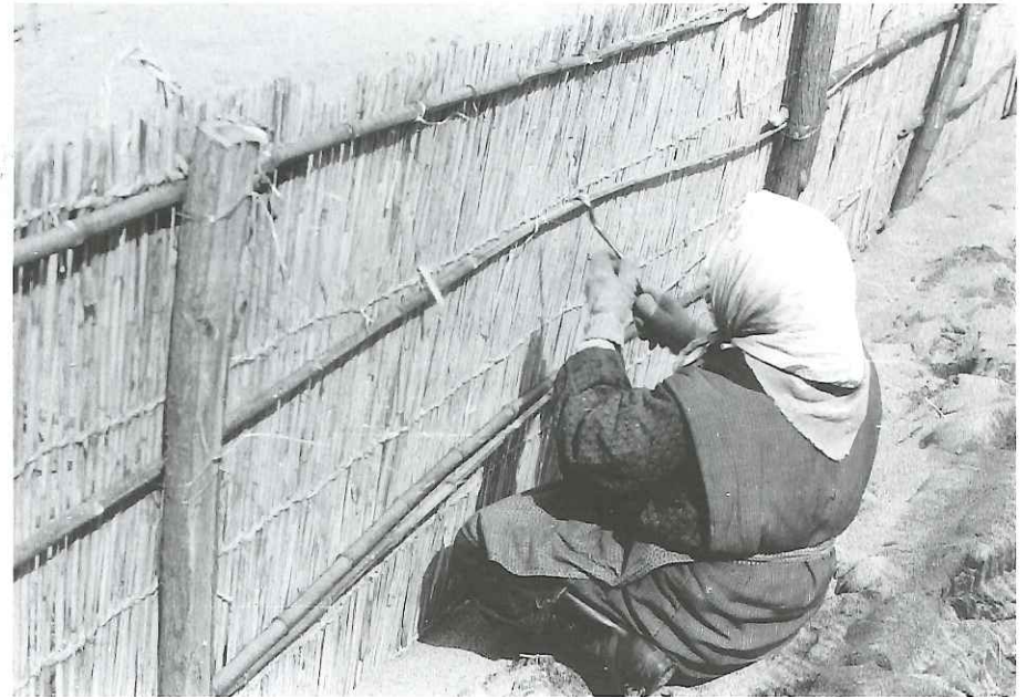
ヨシ簀堆砂垣の作成作業。(大開浜)
