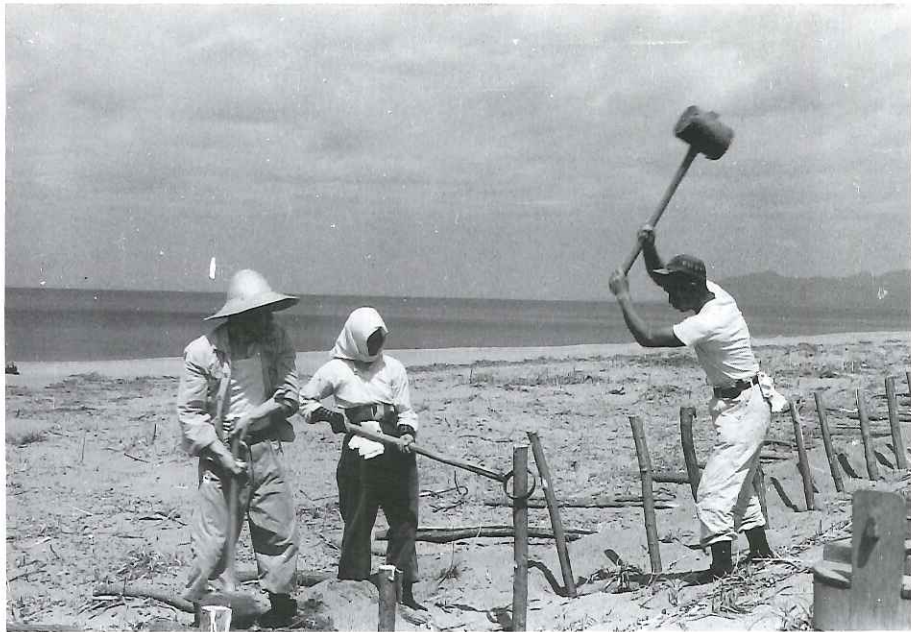
杭を打ち込む。(大開浜)
