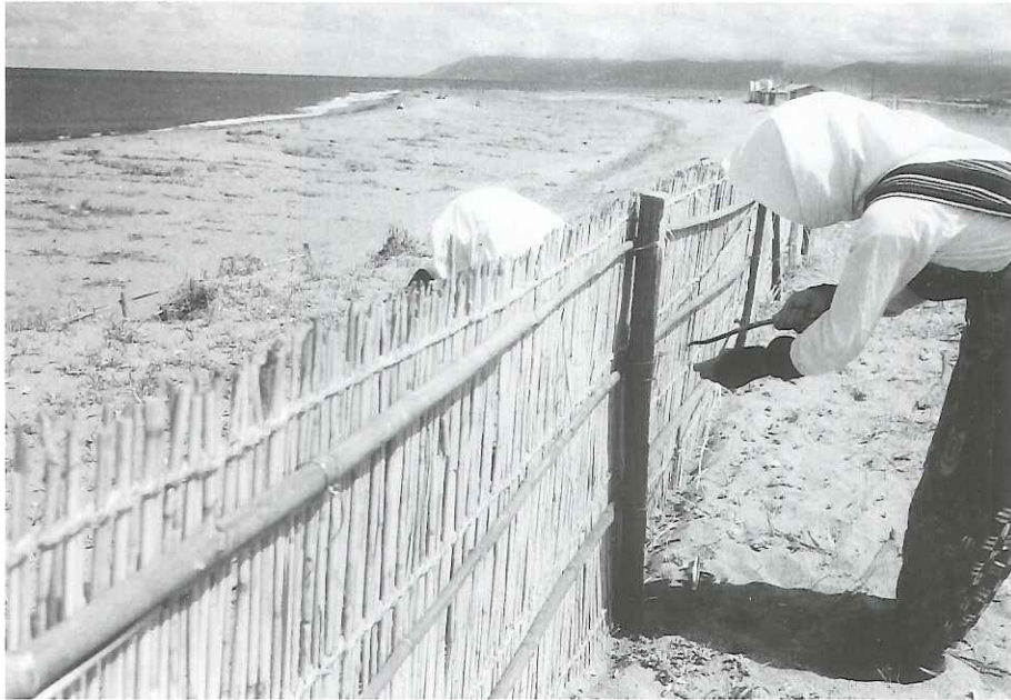
ヨシ簀で作られた堆砂垣の例。(大開浜)
