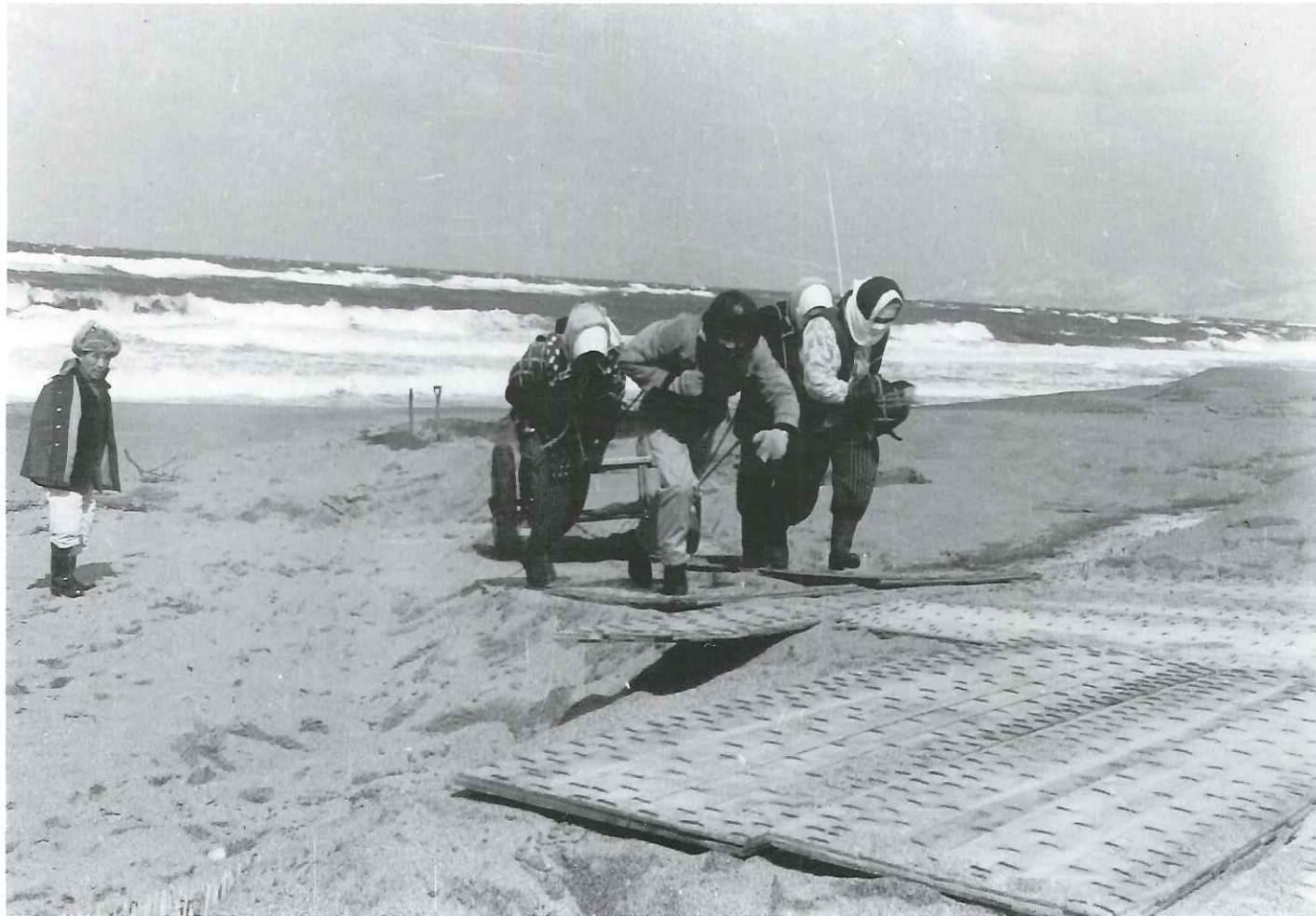
人力による復旧作業。(大開浜 S.36)
