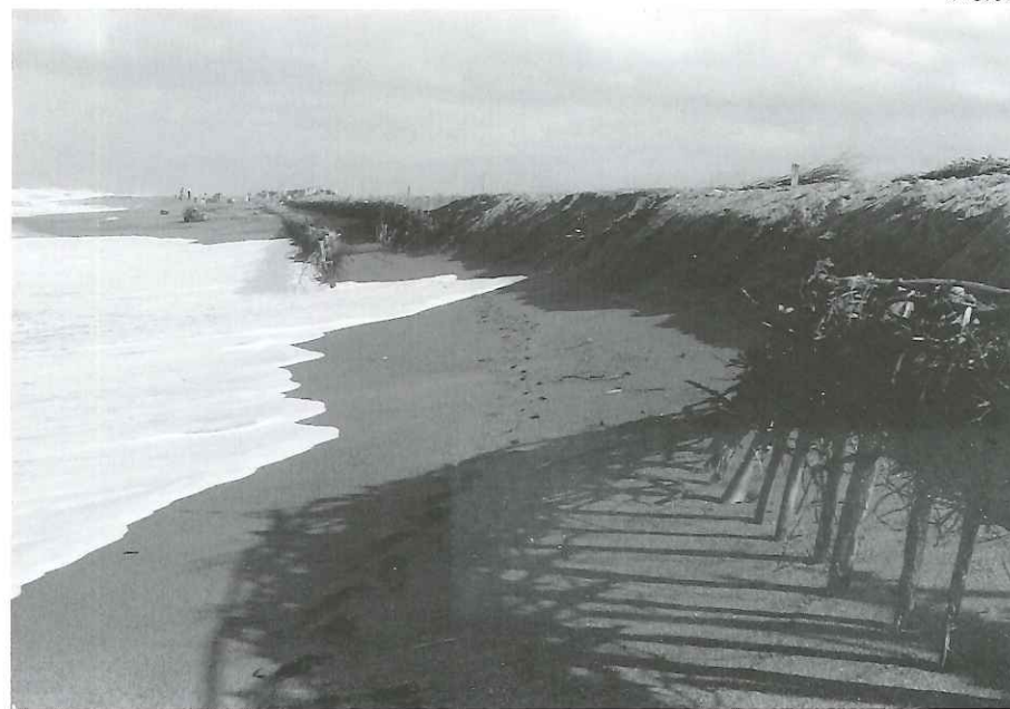
波浪によって破壊された防浪垣。(後谷地)
