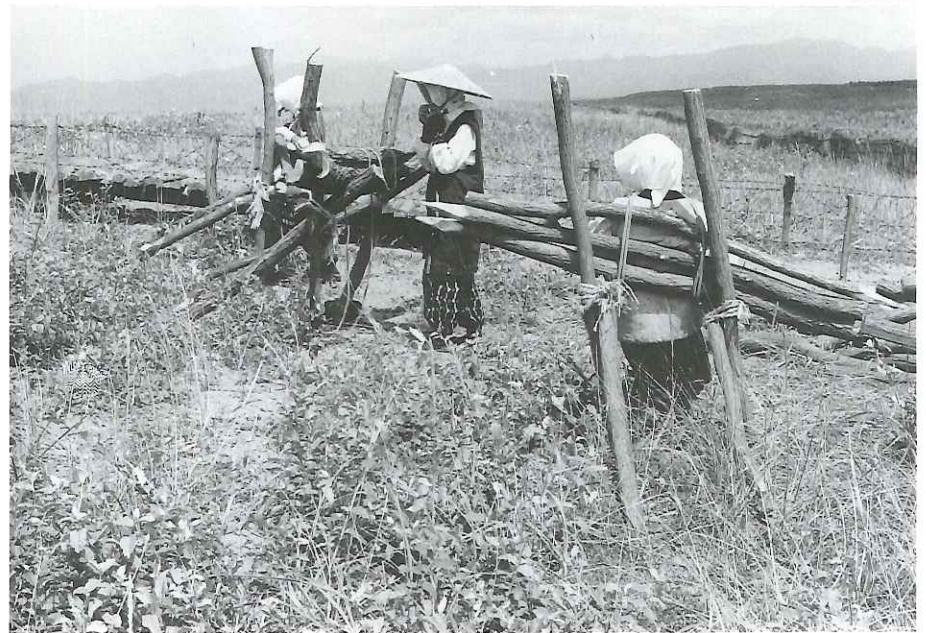
垣造成の現場まで背負って運搬した。(大開浜)
