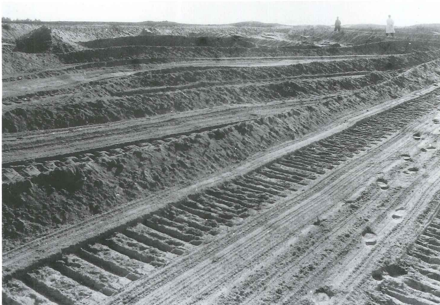
ブルドーザーによる砂丘の造成作業。(大開浜 S.34)
