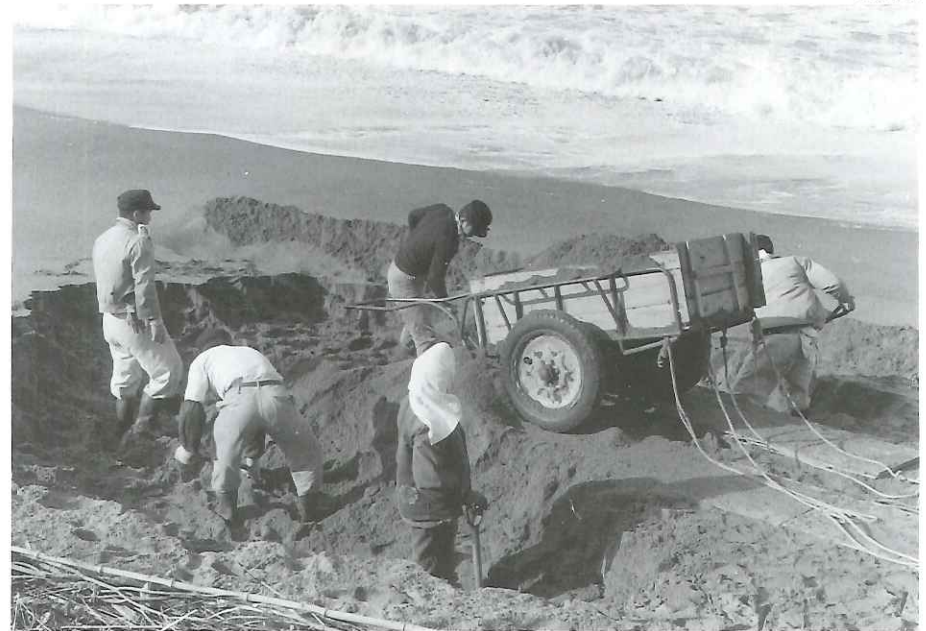
復旧作業は人力によって行われた。(S.36)
