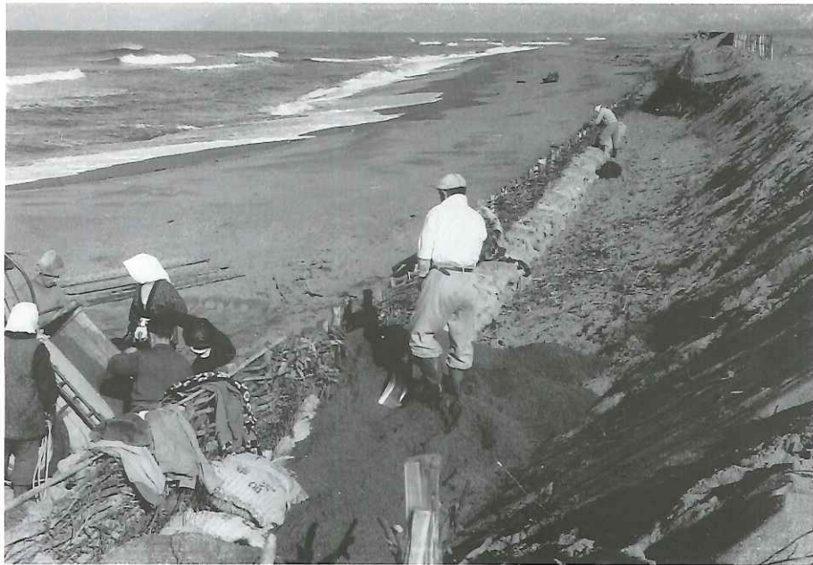
防浪垣による復旧作業。後代になるとコンクリートによる防潮工が施工されるようになるが、当時は垣による復旧が行われた。(後谷地 S.36)
