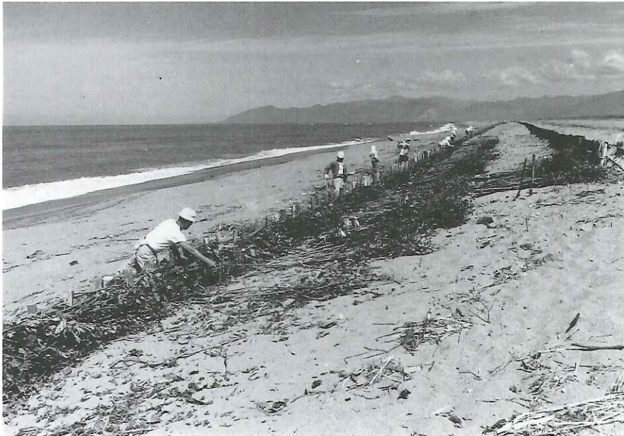
堆砂垣の前方に防浪垣を設け、波浪による浸食を防ぐ。(大開浜 S.38)
