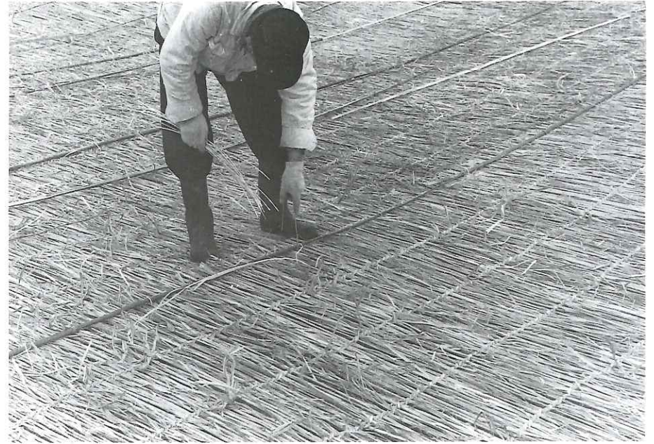
カヤ簀を針金で地面に固定する作業。(S.33)
