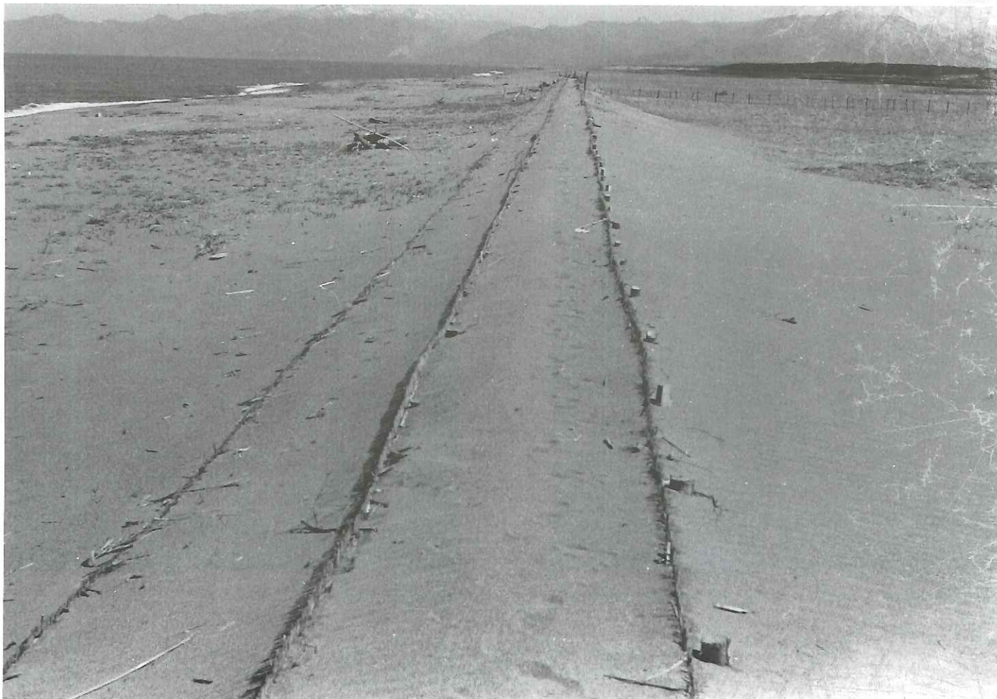
一列目と二列目の間に三列目の堆砂垣を造成し、砂丘を高くする。(大開浜 S.38)
