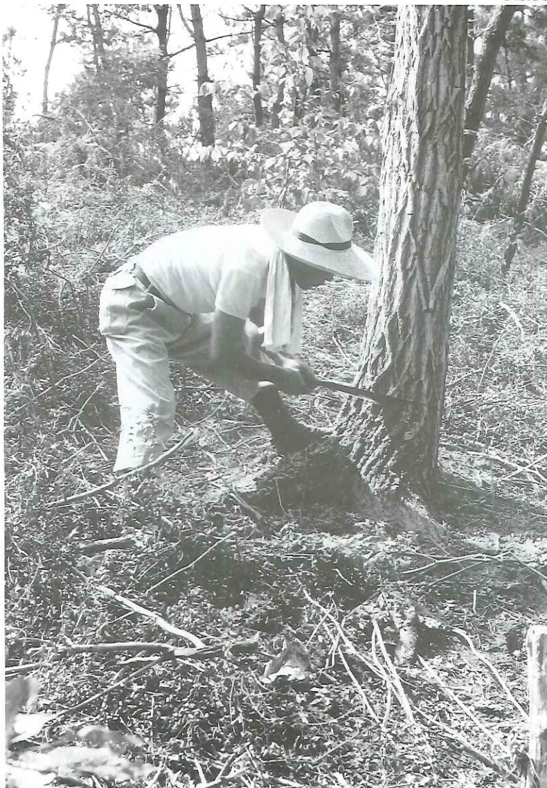
堆砂垣の杭には、後谷地国有林に生育しているニセアカシアを用いた。 (後谷地 S.38)
