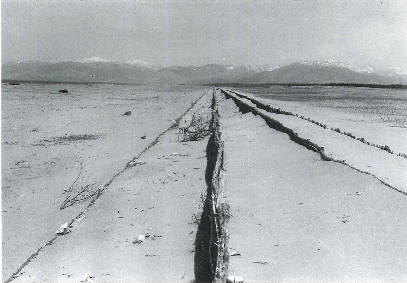
造成された砂丘の頂部は、風によって浸食されないよう柵で固定する。(大開浜 S.33)
