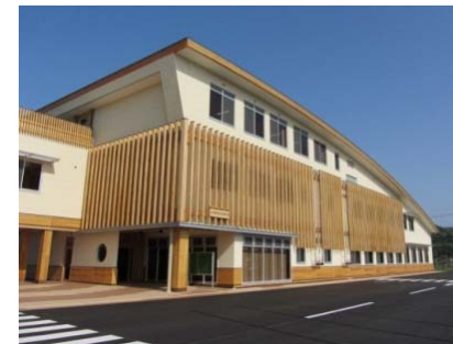
上天草市松島庁舎 (熊本県 上天草市)
