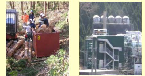
[ 木質バイオマス発電に向けた未利用間伐材等の安定供給 ]
