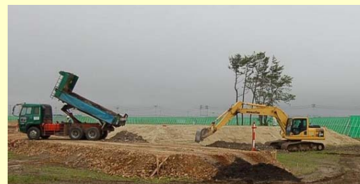
〔生育基盤の整備のための盛土工事〕
