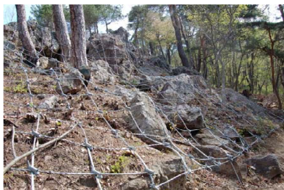
散策路脇の落石防止ネット被覆工
