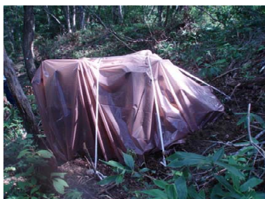
伐根とも薬剤を散布しシートで被覆
