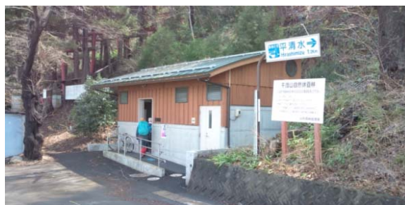
千歳稲荷神社参道入口横に整備した関連施設
