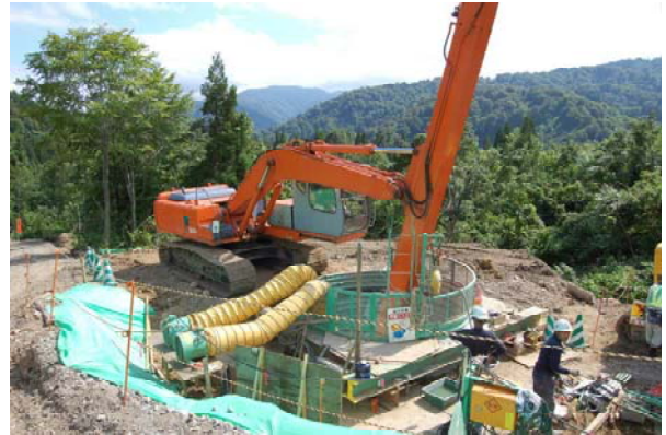
集水井の中での集水管掘削
