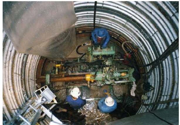
集水井の中での集水管掘削
