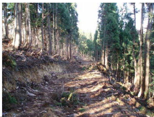
山形署 23年度森林作業道 締固め等が不十分
