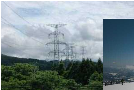
東北電力の送電塔
