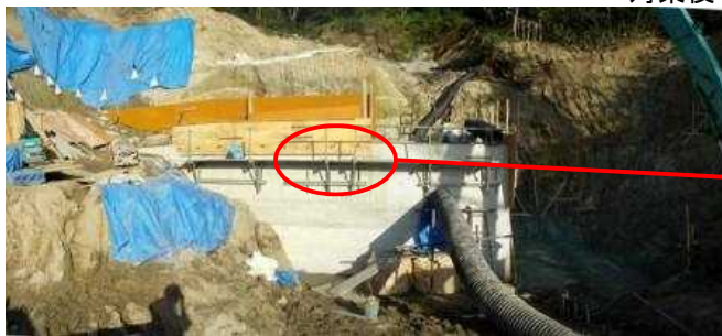
治山工事での「やまがた県産材合板」の利用
