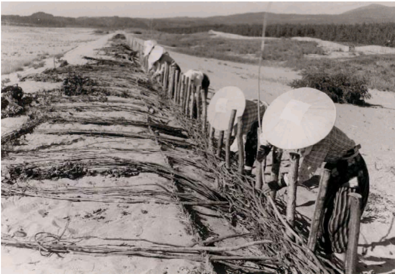
防浪垣の設置作業
