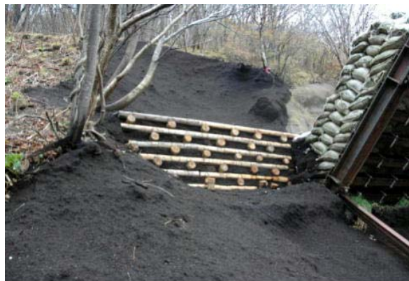
間伐材を活用した土留工 (福浦第二治山工事)
