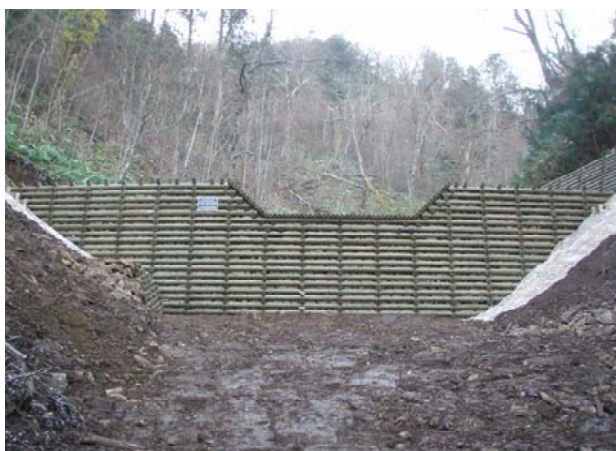
間伐材を活用した校倉式谷止工 (大平沢治山工事)
