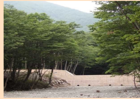
治山ダムと水源かん養保安林(釜石市)
