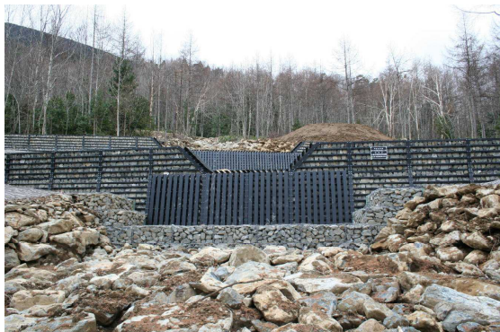
【金平沢鋼製枠谷止工】
