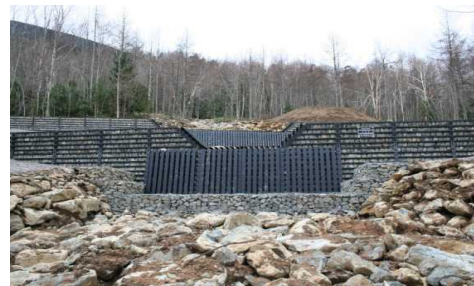
金平沢鋼製枠谷止工
