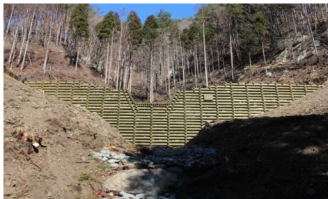
半崎木製校倉式谷止工
