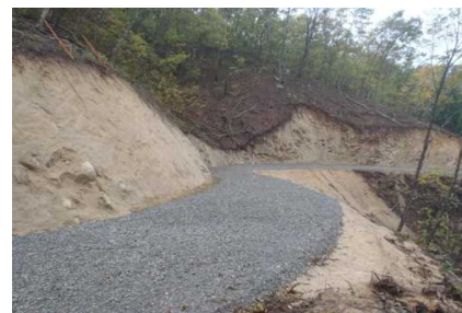
白浜林道専用道新設工事
