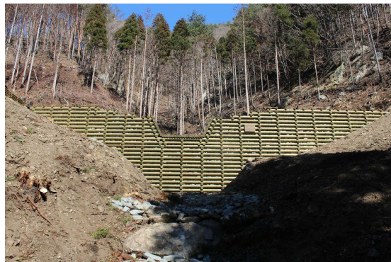
【半崎木製校倉式谷止工】
